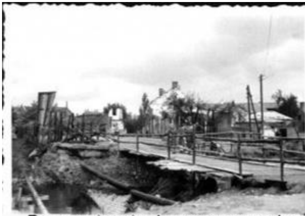
De provisorisch gerepareerde brug bij Axel
